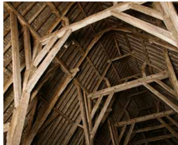
Knoteikenhout is extra sterk en dus prima geschikt voor dakgebinten.
